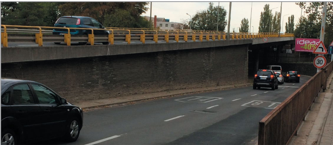
a déli oldalon elegáns mészkő-burkolat: a hatvanas évek igényes építészeti környezete
