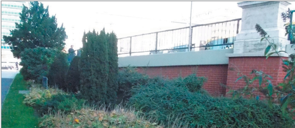
A Baross-híd (még mindig) igényes, téglaburkolatú felhajtója
