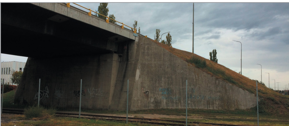
A keleti hídfőre már itt sem került kőburkolat, a ferde vasbeton falak látványa kevésbé tűnik megtervezettnek
