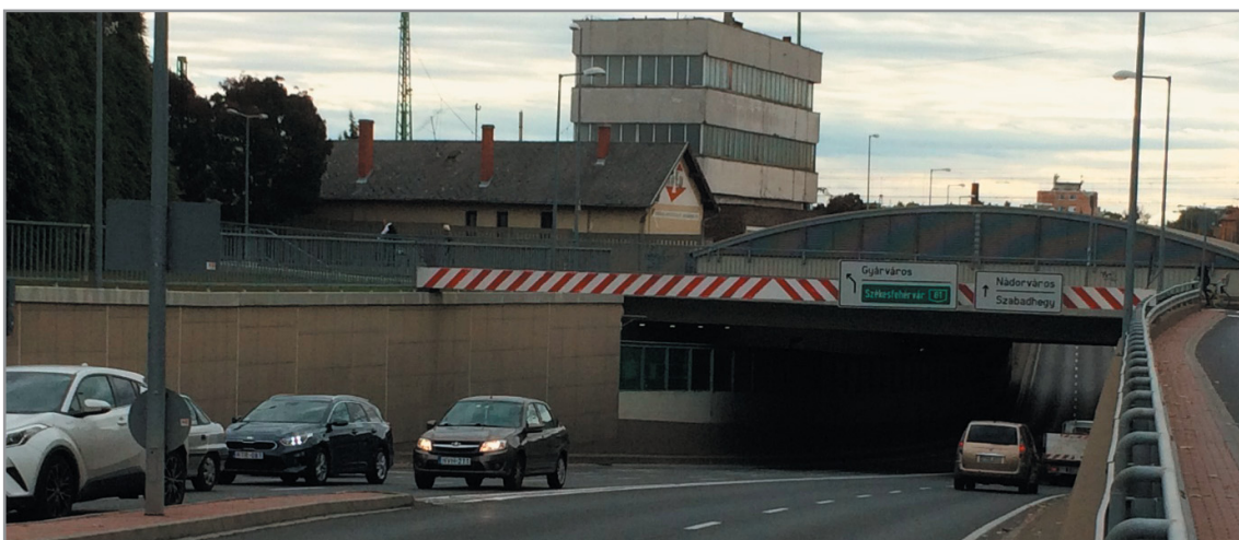
A Nádor-aluljáró lehajtói embertelen vasbeton falak között vezetnek
