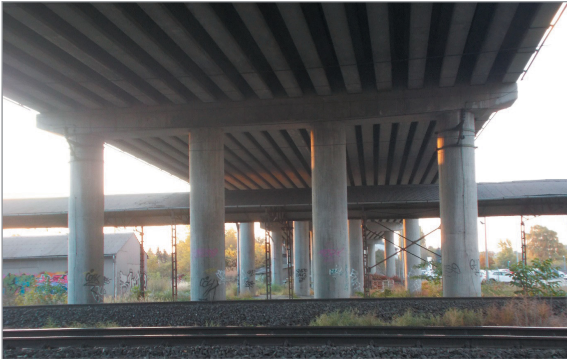
A nyugati felüljáró fejtornyjainak a végét levágással könnyítették ki
