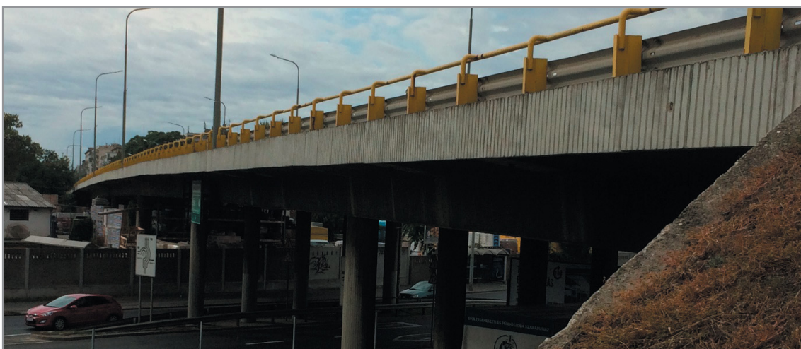
A hídpálya magasságából érzékelhető a Bisinger-híd pályájának függőleges görbülete
