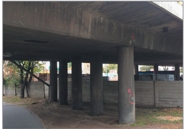
A Bisinger-híd hídfője és közbenső támaszai. Az utólagosan felhelyezett előregyártott vasbeton szegély építészeti minősége messze elmarad a híd korábbi megoldásaitól
