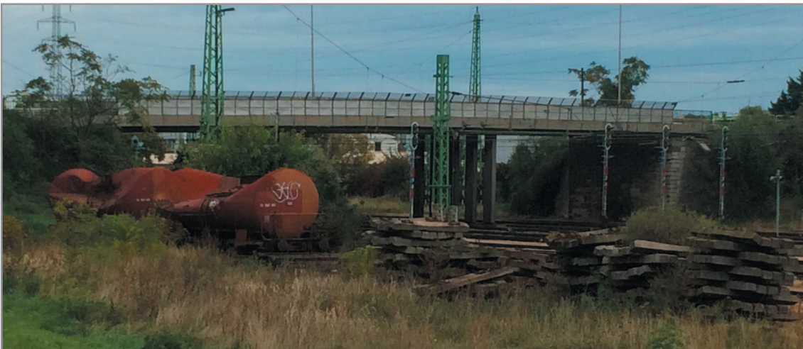
A fehérvári (Pálffy)-híd szerkezete: vasbeton pengepillérekön monolit vasbeton hídszerkezet. Városképi szerepe elenyésző
