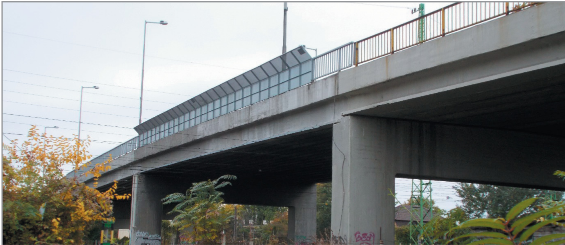
Ipar úti felüljáró: a többnyílású szerkezet eltérő támaszközeit különböző magasságú gerendák hidalják át
