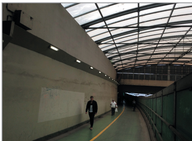
A Nádor-aluljáró gyalogos sávjának a megvilágítása: gyengén sikerült próbálkozás a lámpatestek szerves beépítésére
