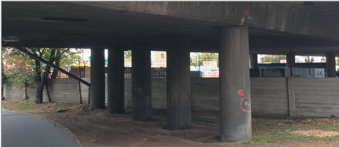
Fejgerenda nélkül támaszkodik a Bisinger-híd szekrénytartója az oszlopsorra
