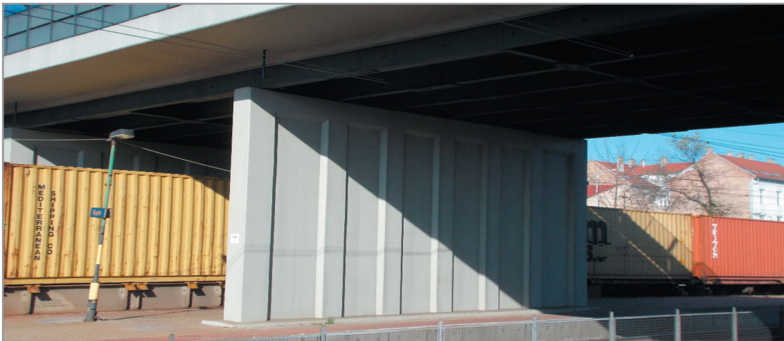
...és pengefalba betonozva
