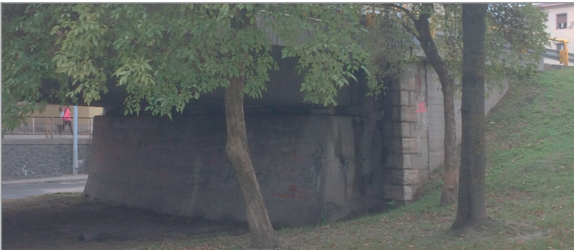
A Bisinger-híd kőburkolattal szépített hídfője
