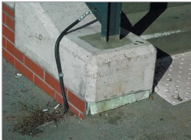
A kötömb egy évszázadot is kibírt, a csempeburkolat pedig néhány év múltán már hiányzik
