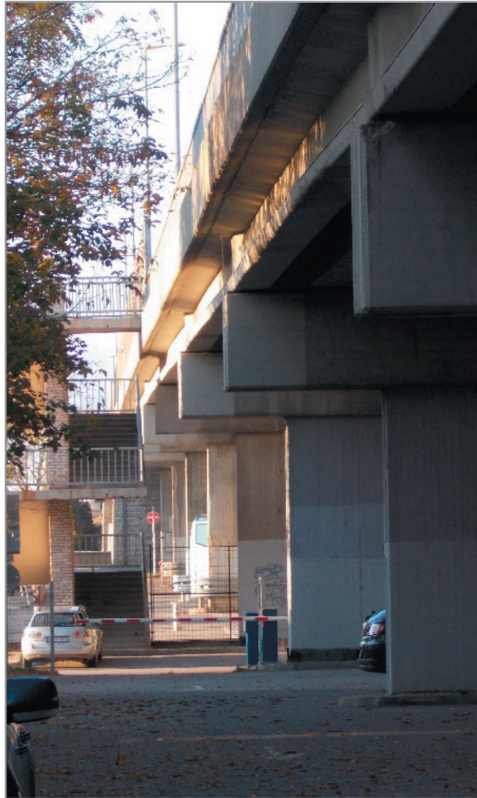
A Széchenyi-híd feljáró szakaszai városi felüljáróként jelennek meg a városképben
