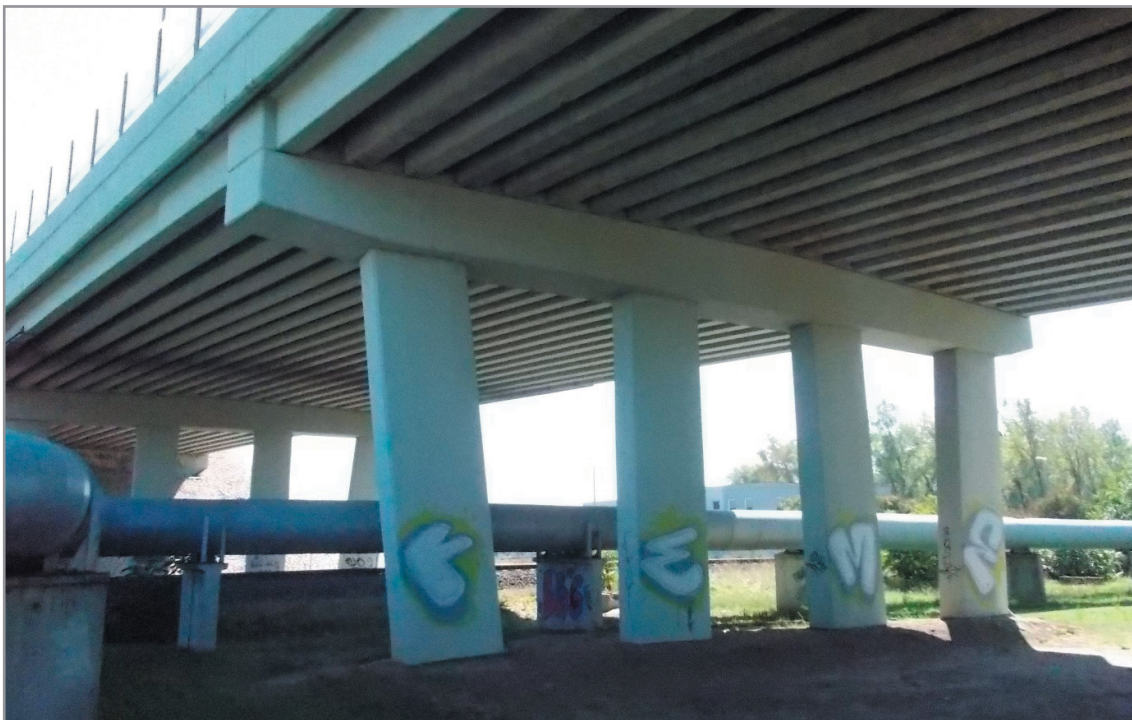
A külső Fehérvári úti felüljáró pillérei kimozdulnak a függőleges vonalból, ennek nyilvánvalóan esztétikai oka van
