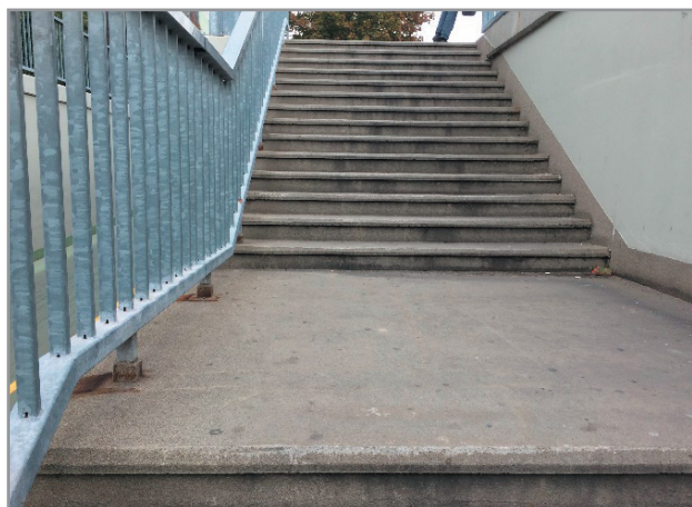
A Nádor-aluljáró műgyantával burkolt lépcsője gyorsan és csúnyán öregszik
