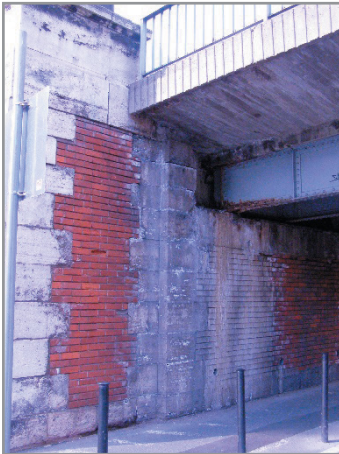
A gerendák feltámaszkodása Baross-hídon. A hídfő a legutóbbi átépítés előtti állapotot mutatja.
