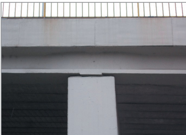
Fejgerenda és híderendák kapcsolata az Ipar úti felüljárón. A különböző magasságú gerendák egymás melletti feltámaszkodásának esztétikai problémájának megoldására még kísérletet sem látunk
