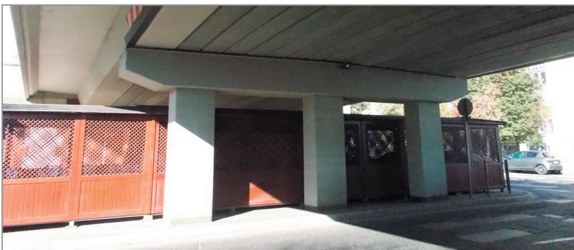
A felhajtó híd már vasbeton szerkezetet kapott
