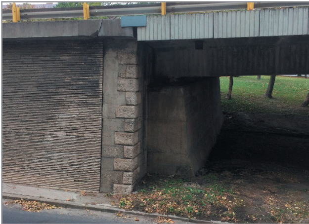
A Bisinger-híd hídfője és közbenső támaszai. Az utólagosan felhelyezett előregyártott vasbeton szegély építészeti minősége messze elmarad a híd korábbi megoldásaitól
