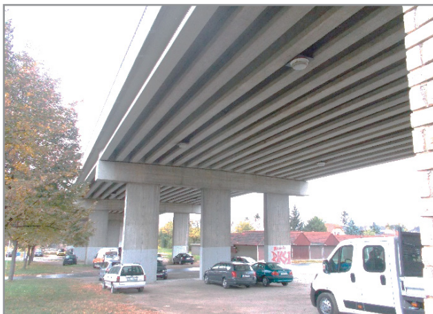
A Széchenyi-híd alsó síkján elhelyezett lámpatesteket rejtett kábelek szolgálják ki
