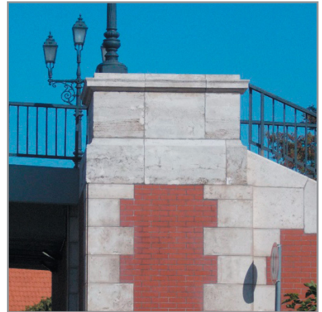
A gerendák feltámaszkodása Baross-hídon. A hídfő a legutóbbi átépítés előtti állapotot mutatja.
