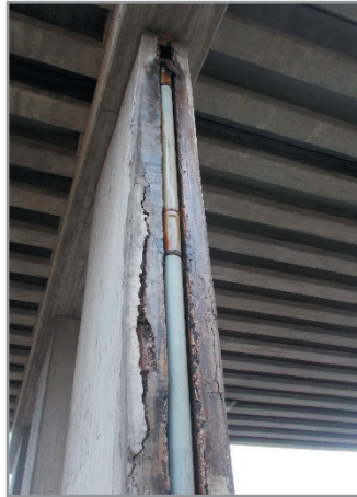
Igényes vízvezetési megoldás a Széchenyi-hídon: a pillér hornyában került elhelyezésre a lefolyó
