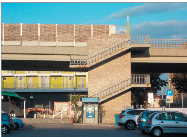
Széchenyi-híd: szép a kőburkolatos monolit vasbeton lépcső
