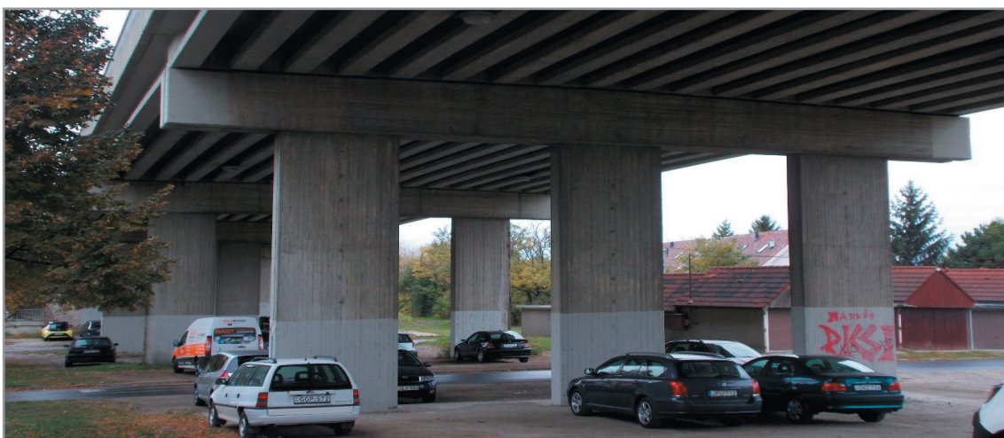
A Széchenyi-híd pengepillérei és fejgerendája. Figyelemreméltó a fejgerenda végének a felsliccelése
