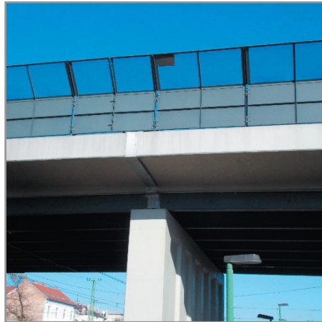
A gerendák feltámaszkodása Baross-hídon. A hídfő a legutóbbi átépítés előtti állapotot mutatja.
