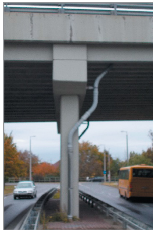
Igényes vízvezetési megoldás a Széchenyi-hídon: a pillér hornyában került elhelyezésre a lefolyó
