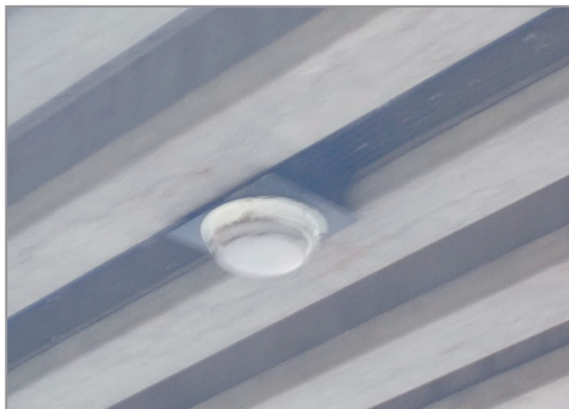
A Széchenyi-híd alsó síkján elhelyezett lámpatesteket rejtett kábelek szolgálják ki
