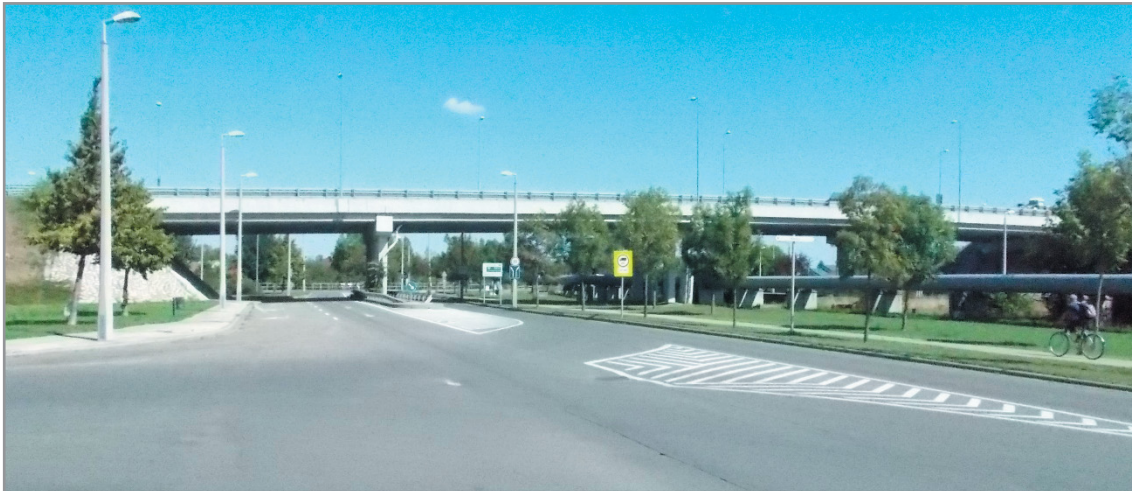
A külső Fehérvári úti felüljáró vonalának lendületét megtörik az erőteljes fejgerenda-végek
