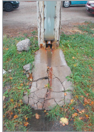
Igényes vízvezetési megoldás a Széchenyi-hídon: a pillér hornyában került elhelyezésre a lefolyó
