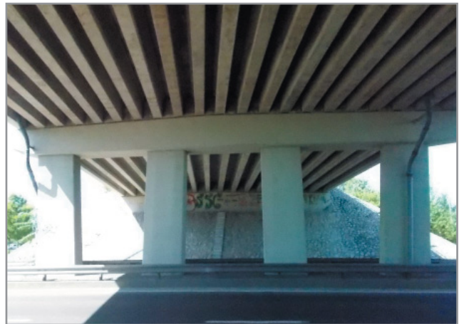
Igényes vízvezetési megoldás a Széchenyi-hídon: a pillér hornyában került elhelyezésre a lefolyó
