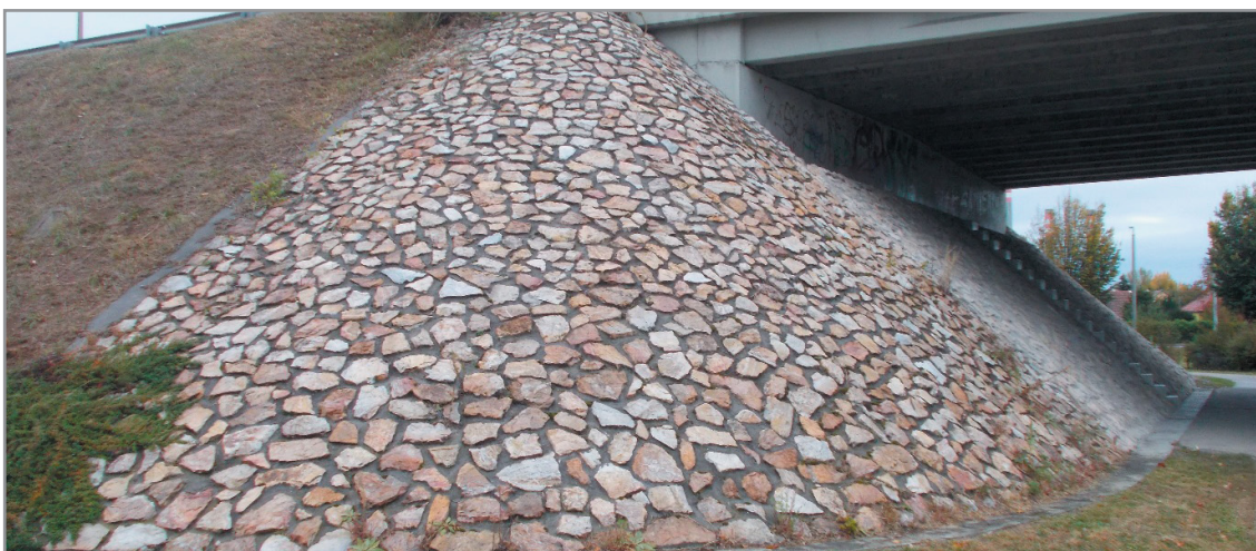
Kőburkolat a külső fehérvári úti felüljáró hídfőjén
