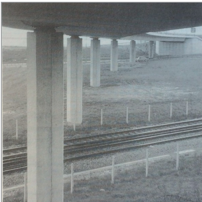
Nyugat-európai hídpillérek. Jellemző a monolit szekrénytartó alkalmazása és a fejgerenda rejtett megoldása. A képek forrása: Pritchard, Brian 1992.
