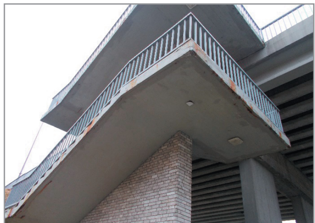
Széchenyi-híd: szép a kőburkolatos monolit vasbeton lépcső
