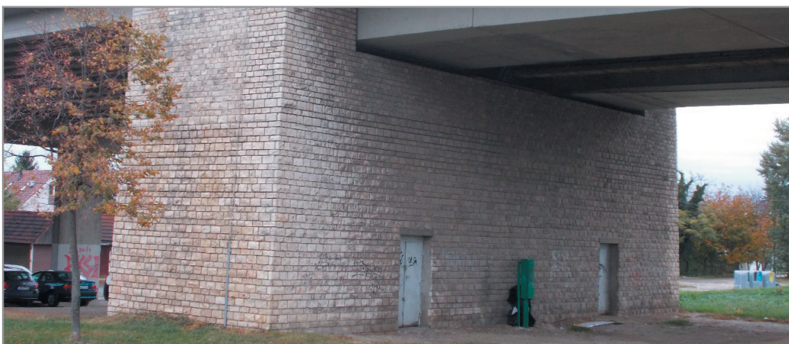
A Széchenyi-híd kőburkolatú pillére, mely a mederhidat és a felhajtó hidat választja el egymástól
