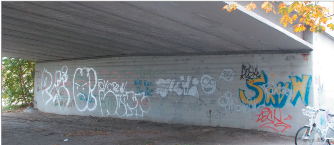
A hídfő egyszerű, sallangmentes építészeti (?) megoldása az Ipar úti felüljárónál
