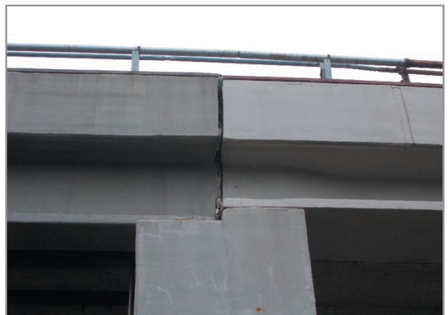
Fejgerenda és híderendák kapcsolata az Ipar úti felüljárón. A különböző magasságú gerendák egymás melletti feltámaszkodásának esztétikai problémájának megoldására még kísérletet sem látunk
