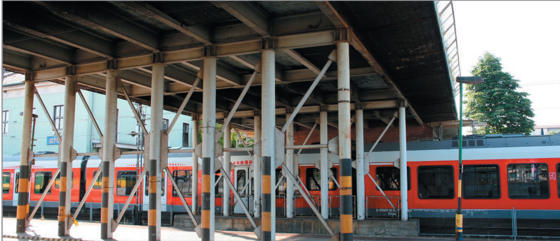
A Baross-híd közbenső acéloszlopai még szabadon...
