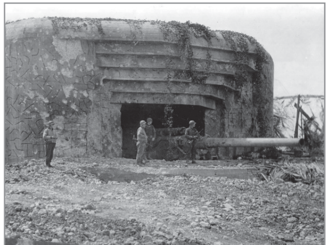
Une des deux casemates de la batterie de Crisbecq avec un canon Skoda de 210 mm Une autre vue chez Allison collection:... https://bunkerblog.eu/battered-normandy/p012956-jpg/
