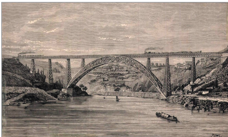
8. ábra: A Gustave Eiffel által tervezett acél rácsostartós ívhíd Porto mellett 18
